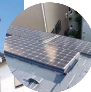
屋根葺材の代わりに 太陽光発電パネルを 乗せる工法です
