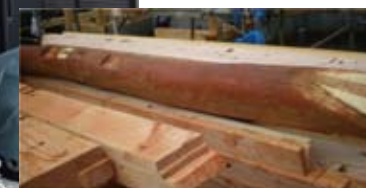
建て替え前の家の大きな梁を 構造材に再利用しました
