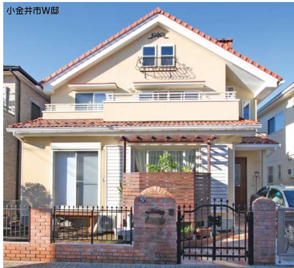
玄関までのアプローチは煉瓦の縁取りが素敵です。バーゴラの木組みも見事にできあがりました。広々としたバルコニーもお気に入りです。
